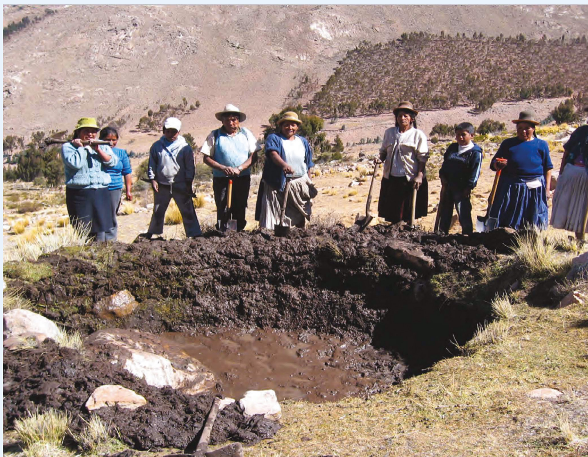
Membres des communautés aymaras des hauts plateaux de la province de Puno réalisant des travaux de captation de l'eau grâce aux savoirs traditionnels appris des communautés de la province d'Ayacucho (Pérou, 2017). © CESATCH
